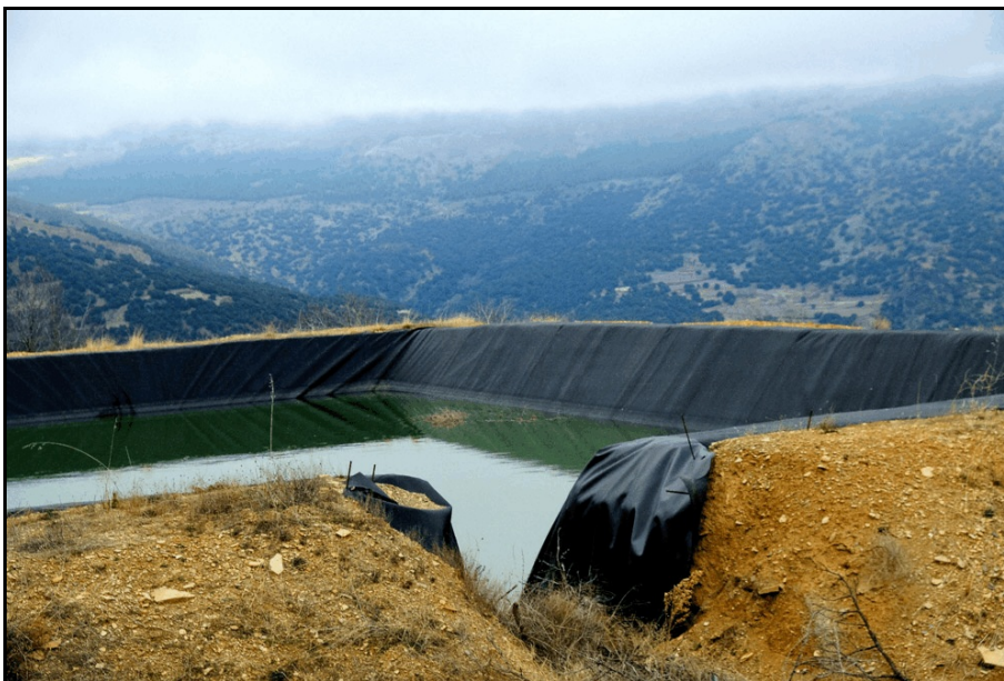
Foto nº 11. Aspecto de las balsas de riego de grandes dimensiones que perjudican al normal aprovechamiento escalonado, ladera abajo, de las aguas de careo de la Acequia de Bérchules.
