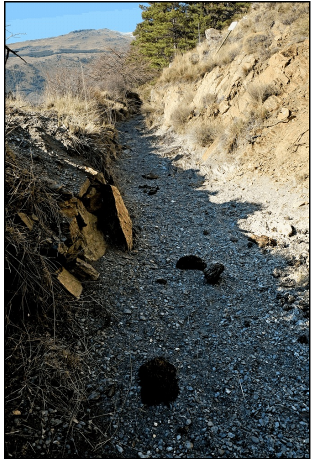
Foto nº 14. Cagadas de vaca en la base de la acequia de careo de Bérchules. Su gran número y volumen suponen un deterioro en la normal circulación del agua, sobretudo al inicio y cese del careo estacional, cuando el volumen de agua circulante por la acequia no es importante.
